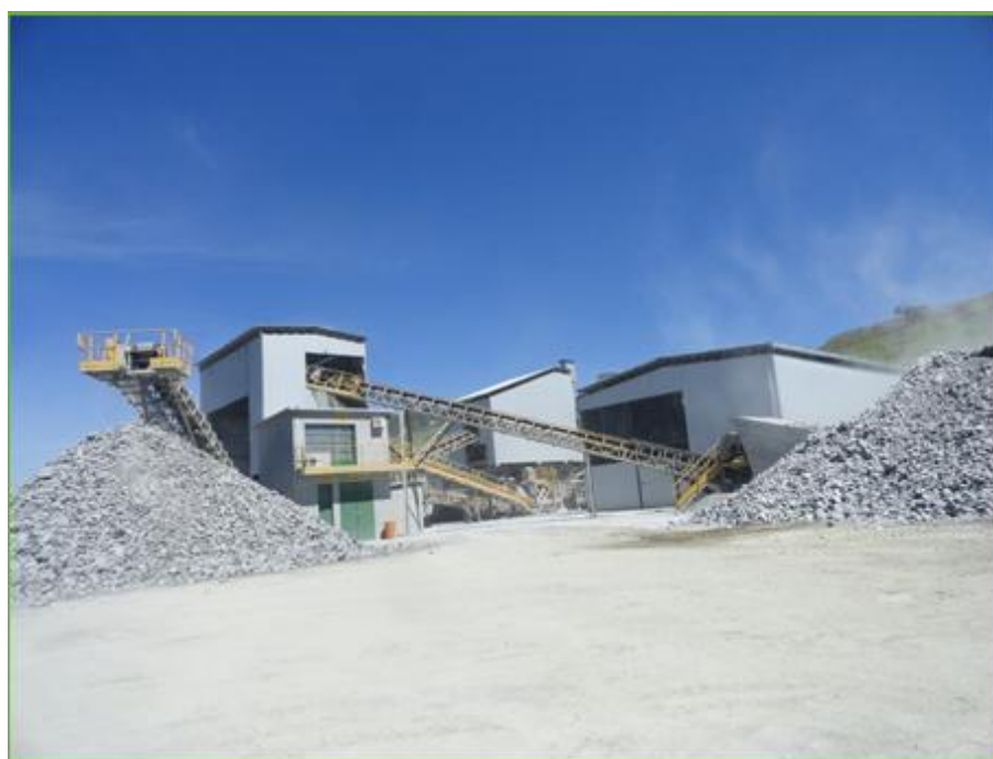
Figura 25: Panorama parcial da unidade de britagem secundária e pátio de estocagem de produtos.
