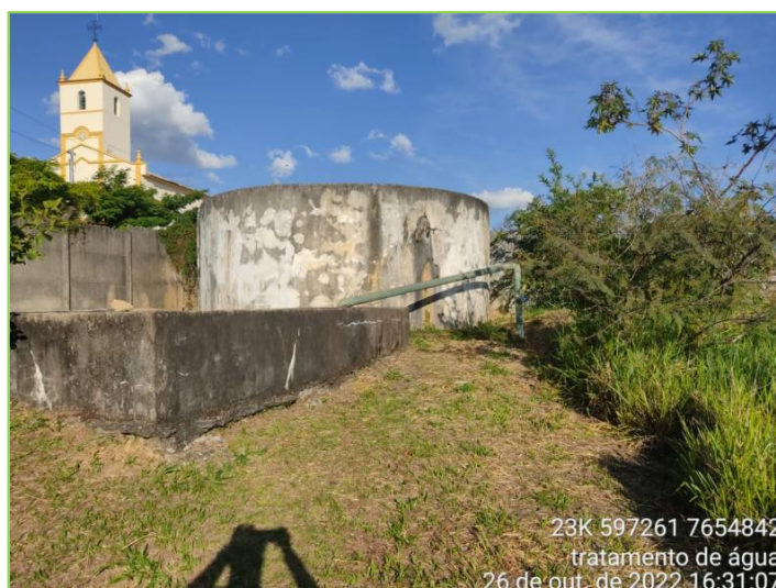
Figura 248: Reservatório redondo é o sistema de filtragem e o reservatório quadrado e o reservatório quadrado e subterrâneo é a caixa de água potável que recebe as pastilhas de cloro.
