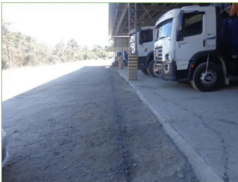
Figura 17: Garagem de Veículos com solo impermeabilizado.
