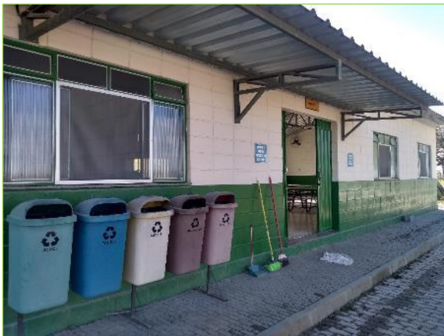
Figura 51: Lixeiras (20 litros) instalada ao lado da cozinha e do refeitório.
