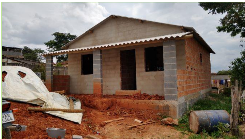
Figura 209: Casa em construção no Povoado de Pitangueiras, em outubro de 2022.
