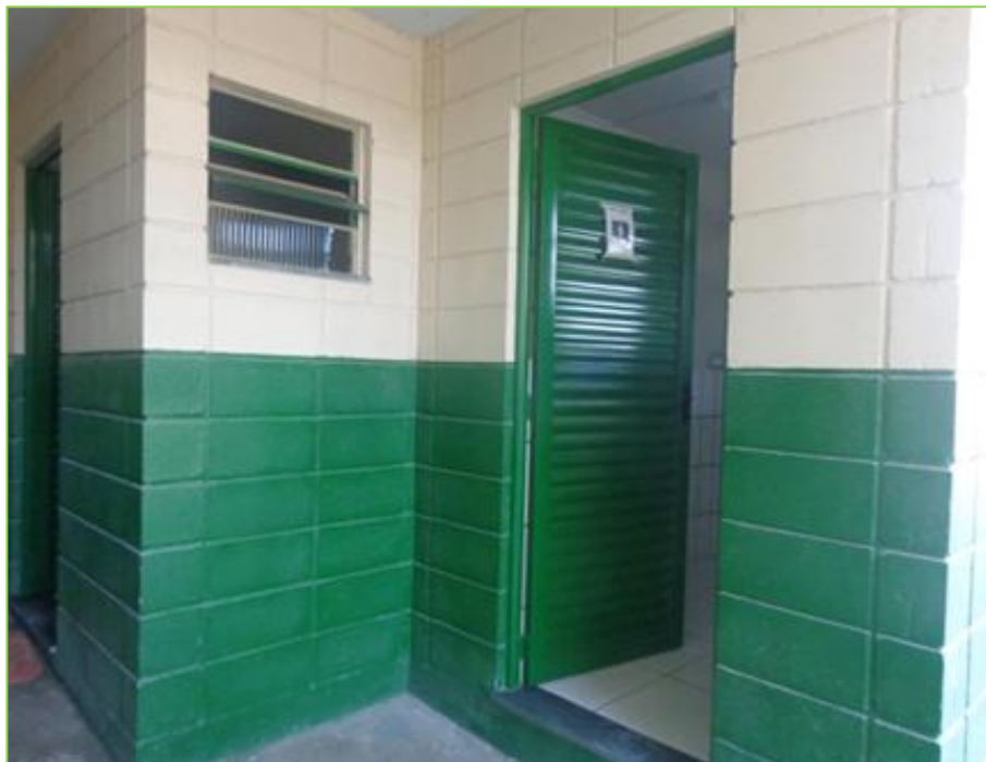
Figura 14: Banheiros e vestiários.
