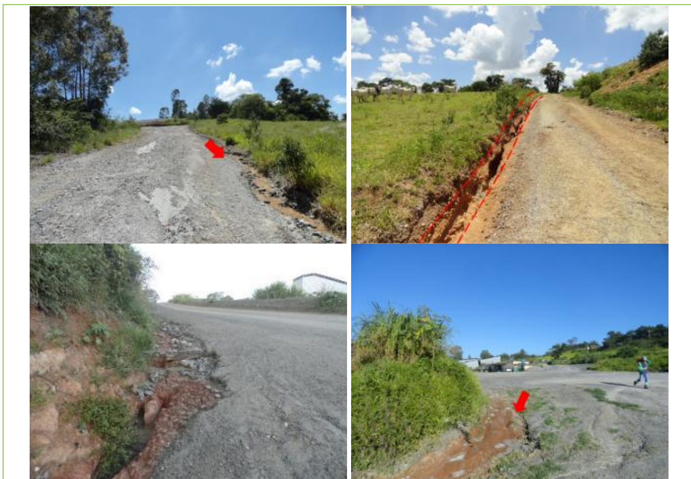
Figura 88: Processos erosivos laminares e lineares formados pela exposição do solo ao longo de acessos e trilhas no interior da área da Mineração Barroso. Tais porções de terreno deverão ser alvos de preocupação ao longo da operação do projeto minerário, devido a sua maior probabilidade de carrear sedimentos à jusante, onde flui os cursos d'água da bacia hidrográfica do Rio Elvas e pela eventual evolução das mesmas.
