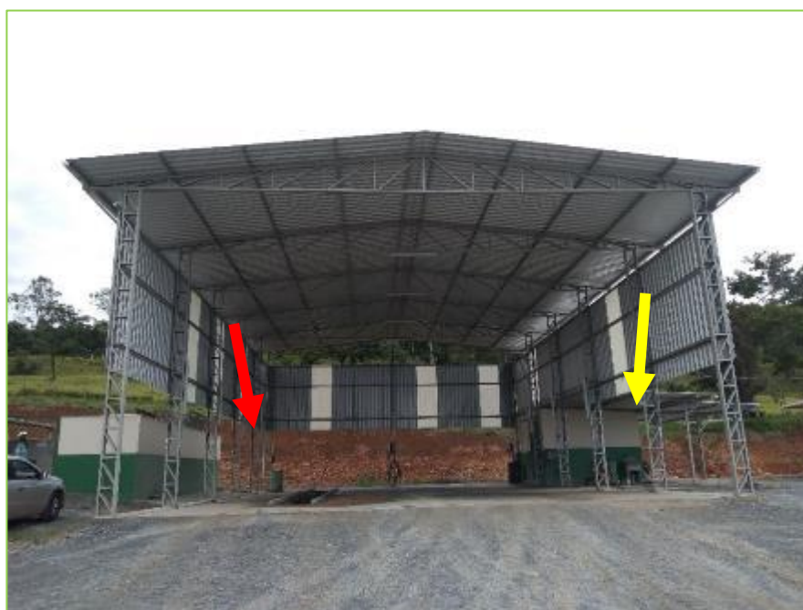
Figura 19: Lavador de veículos instalado na Mineração Barroso. Seta indicadora em vermelho do local de lavagem de veículos e em amarelo do local de lavagem de peças e equipamentos.
