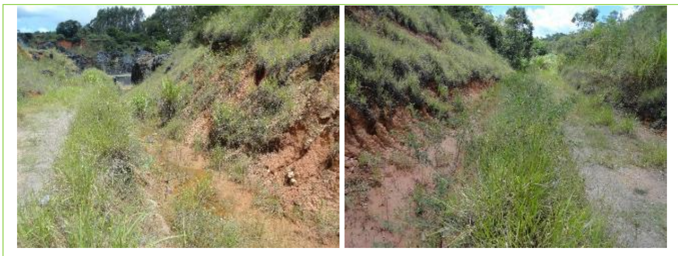
Figura 101: Vala escavada em solo, localizada a oeste da ADA.
