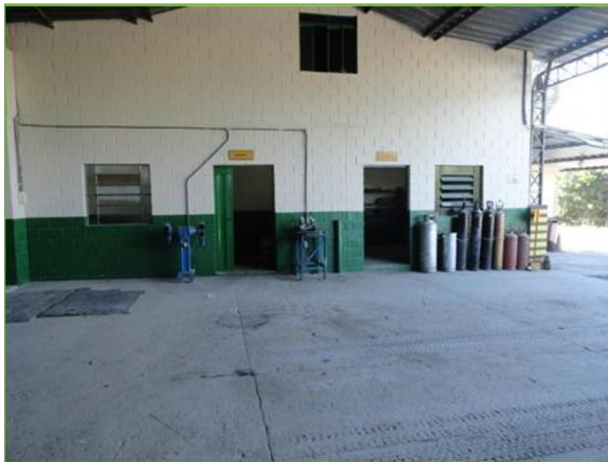
Figura 18: Sala de manutenções mecânicas (a direita) e sala de manutenções elétricas (a esquerda) ambas as estruturas com solo impermeabilizado.
