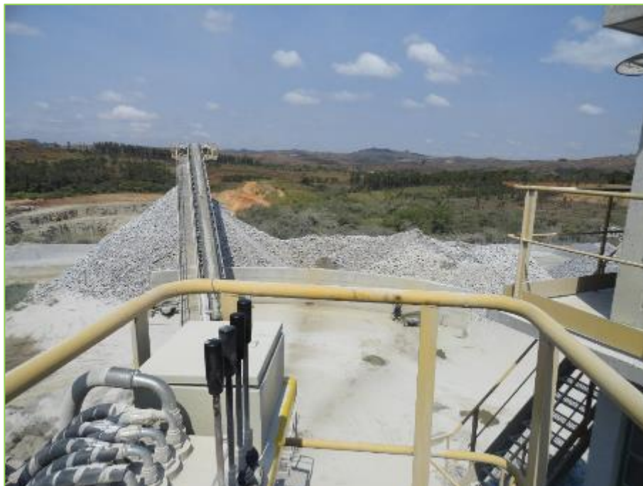
Figura 24: Vista da correia transportadora móvel a partir da área de abastecimento do britador primário.
