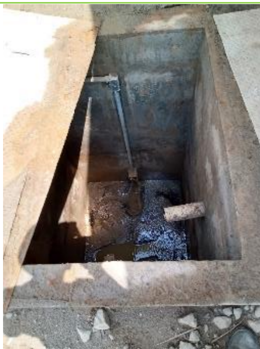
Figura 48: Caixa desarenadora instalada antes da CSAO com o objetivo de reter os sólidos que poderiam prejudicar o bom funcionamento da CSAO.
