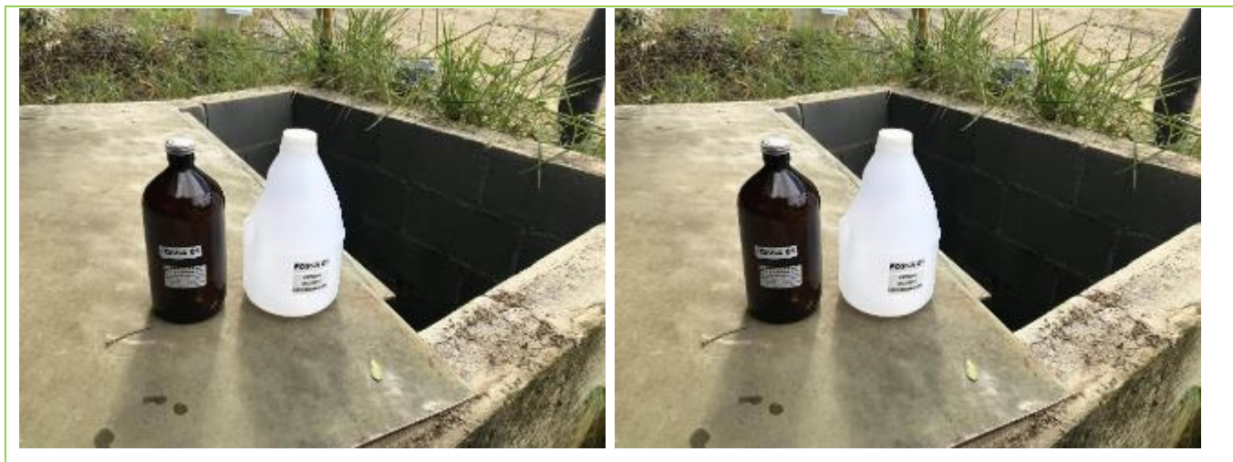
Figura 47: Fossa séptica que trata o efluente sanitário doméstico gerado na unidade Pedreira da mineração barroso.
