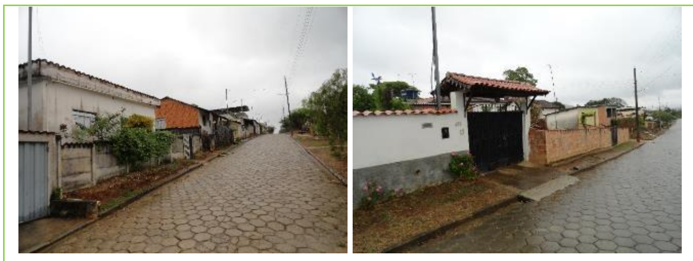
Figura 194: Padrão construtivo das residências encontradas no Povoado de Pitangueiras.
