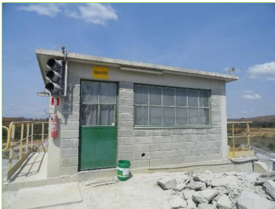
Figura 22: Sala de Controle da Unidade de Tratamento de Minério- UTM.
