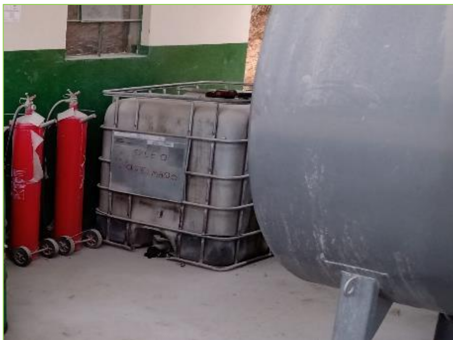
Figura 53: Bombona de óleo usado acondicionada na bacia de contenção do posto de combustível do empreendimento.
