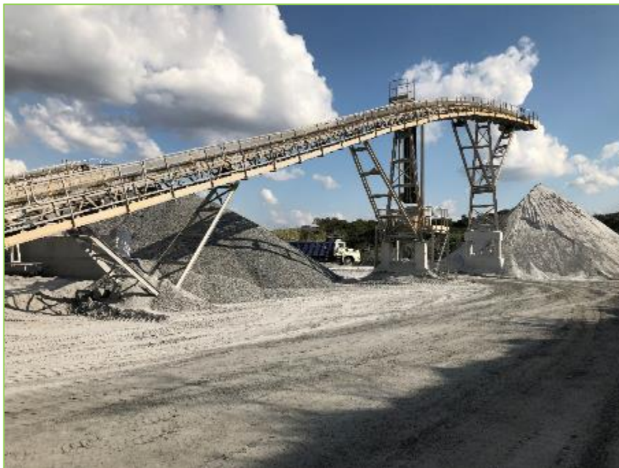
Figura 36: Transportadora de Correias TC16 formando uma pilha de pó de calcário siderúrgico alto a direita e Transportadora de Correias TC15, que realizando o empilhamento de Brita 1.
