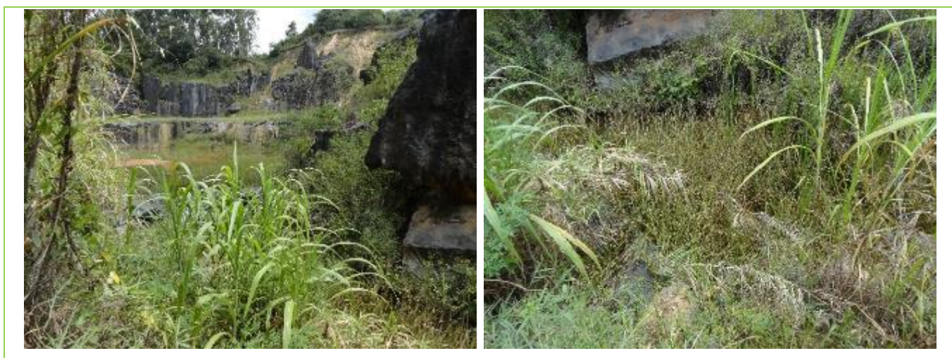
Figura 102: Acumulo de água pluvial nas proximidades da cava da mina P-2.
