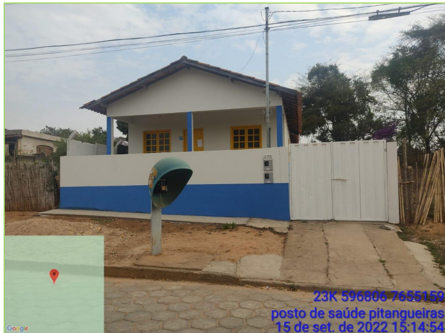
Figura 217: Posto de Saúde da Comunidade de Pitangueiras.
