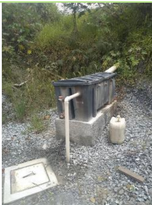
Figura 49: Caixa separadora de água e óleo instalada no empreendimento.
