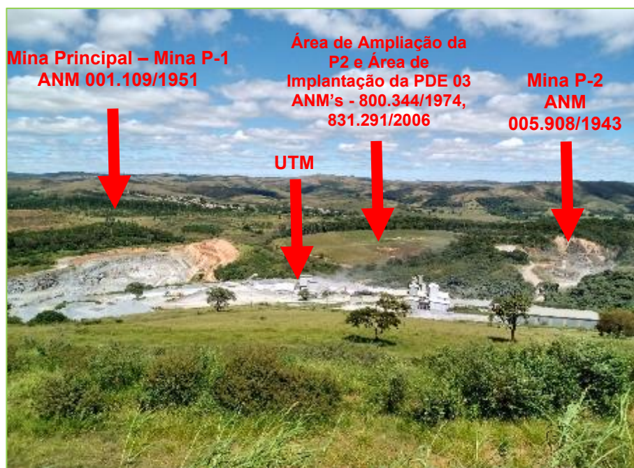
Figura 6: Vista a partir a pilha de estéril, em direção sul, da Minas P-1 e P-2, área de expansão e UTM.
