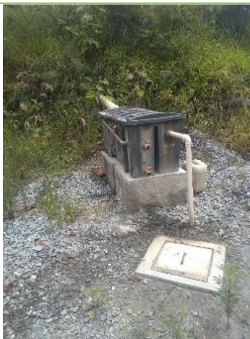
Figura 49: Caixa separadora de água e óleo instalada no empreendimento.
