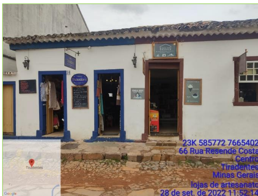
Figura 232: “Empório Heliadora” Largo das Forras em Tiradentes
