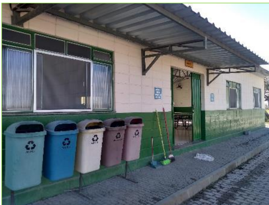
Figura 40: Lixeiras (20 litros) instalada ao lado da cozinha e do refeitório.
