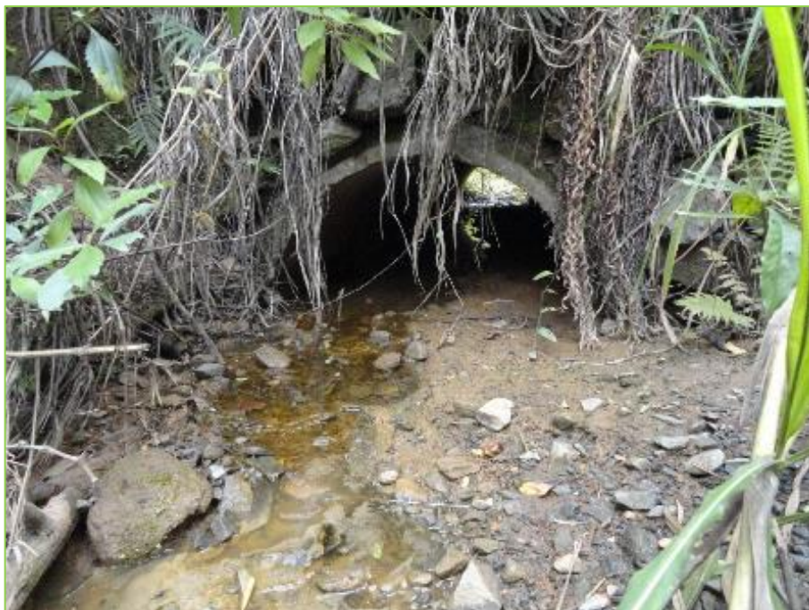
Figura 78: Área 4 - Bueiro que transpõem o fluxo pluvial da vala para a propriedade vizinha do empreendimento.
