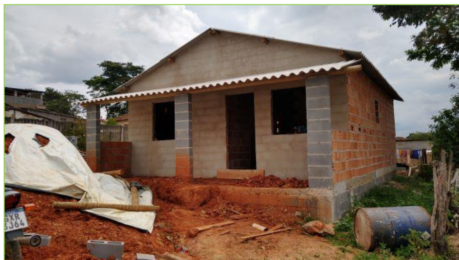
Figura 185: Casa em construção no Povoado de Pitangueiras, em outubro de 2022.
