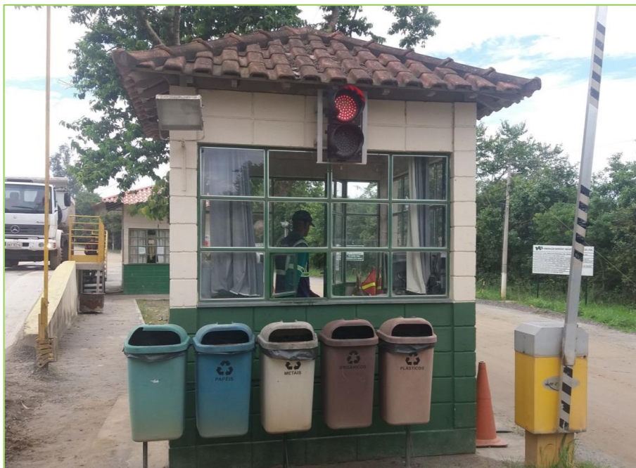
Figura 41: Lixeiras (20 litros) instalada ao lado da portaria.
