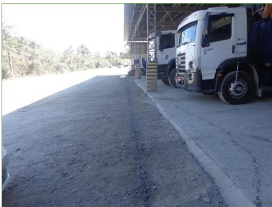
Figura 15: Garagem de Veículos com solo impermeabilizado.
