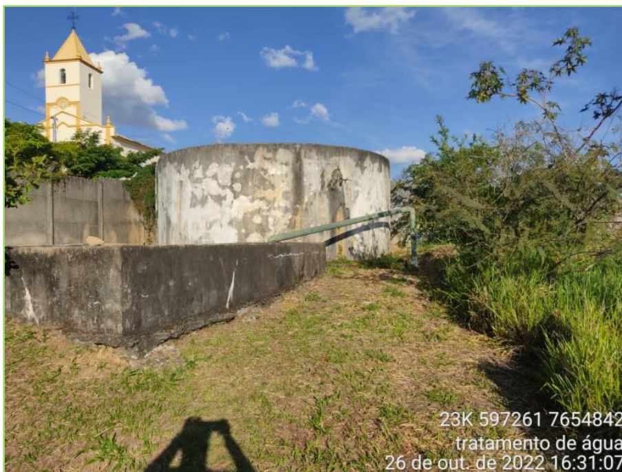
Figura 224: Reservatório redondo é o sistema de filtragem e o reservatório quadrado e o reservatório quadrado e subterrâneo é a caixa de água potável que recebe as pastilhas de cloro.
