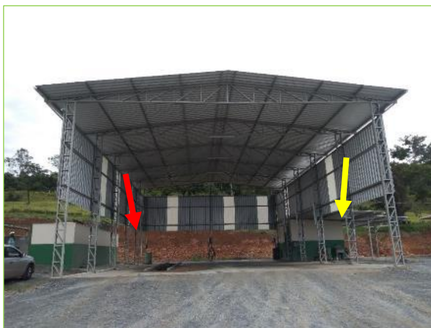
Figura 17: Lavador de veículos instalado na Mineração Barroso, com piso impermeável e canaletas para coletar os efluentes oleosos e direcioná-los até caixas separadoras de água e óleo. Seta indicadora em vermelho do local de lavagem de veículos e em amarelo do local de lavagem de peças e equipamentos.
