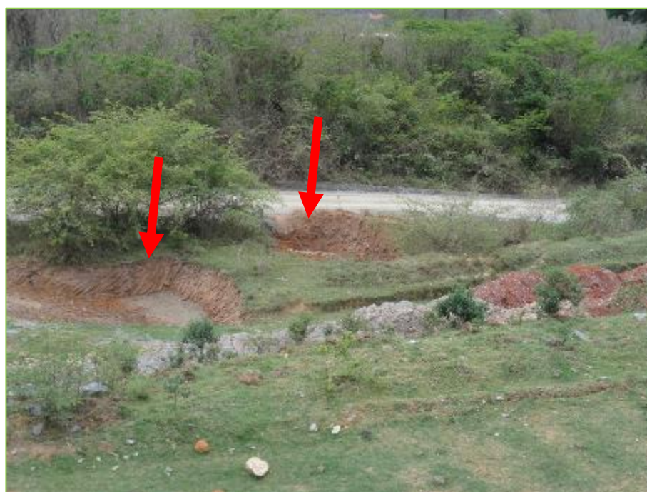
Figura 34: Exemplo de bacias já existentes na Mineração para contenção de sedimentos. Seta em vermelho com a indicação das estruturas.
