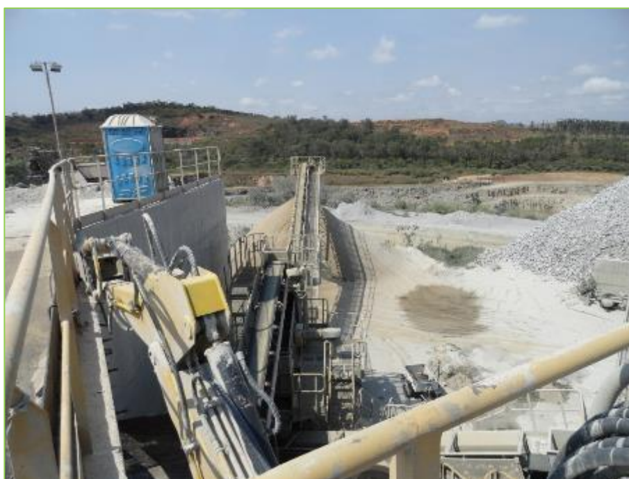
Figura 21: Vista da correia transportadora móvel a partir da área de abastecimento do britador primário.
