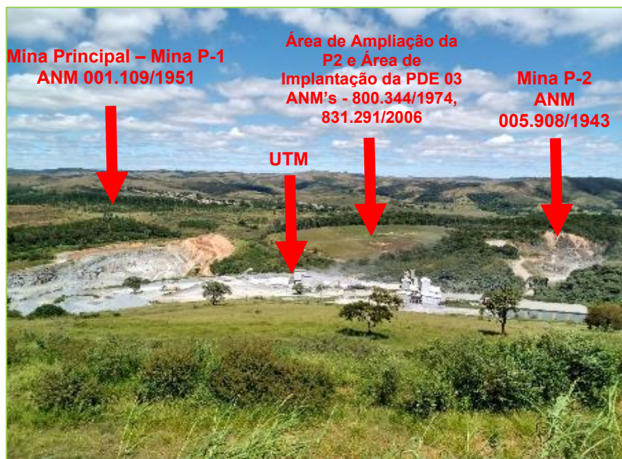
Figura 4: Vista a partir a pilha de estéril, em direção sul, da Minas P-1 e P-2 e UTM.
