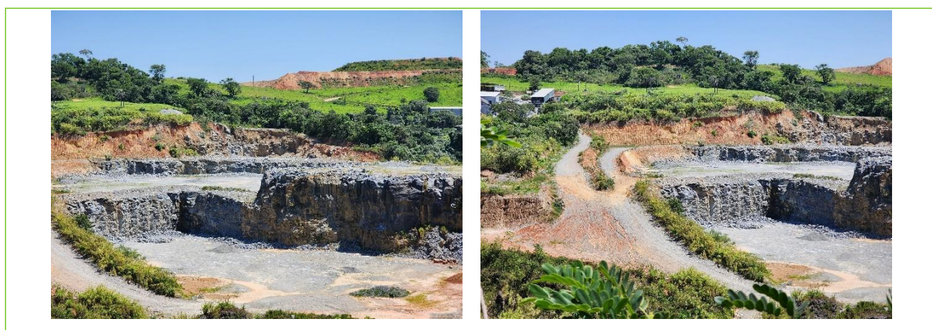
Figura 146: Área Antropizada caracterizada pela instalação de atividade minerária. Fonte: Virtual Engenharia Ambiental, 2025.
