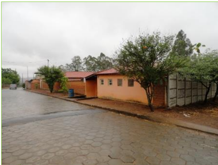
Figura 173: Fachada da Escola Municipal Aquino Carlos, no Povoado de Pitangueiras.
