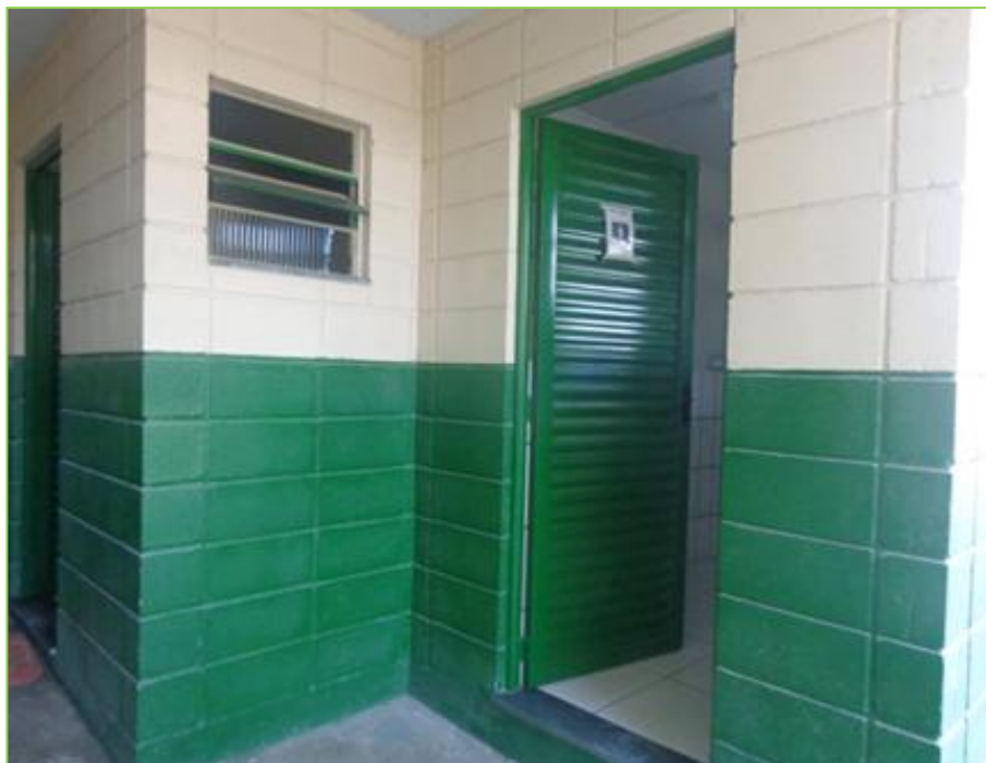
Figura 12: Banheiros e vestiários.
