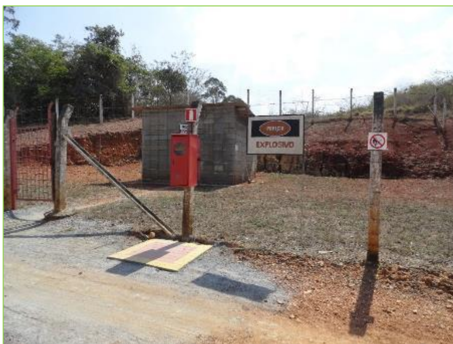
Figura 25: Paio de explosivos, construído nos moldes exigidos pelo exército brasileiro.
