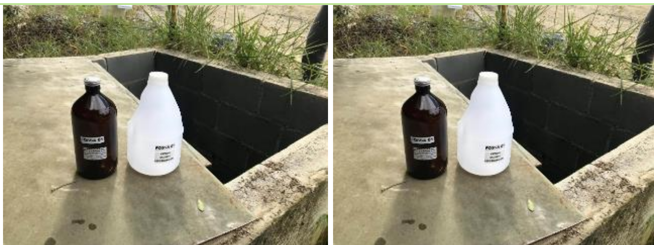
Figura 36: Fossa séptica que trata o efluente sanitário doméstico gerado na Mineração Barroso.
