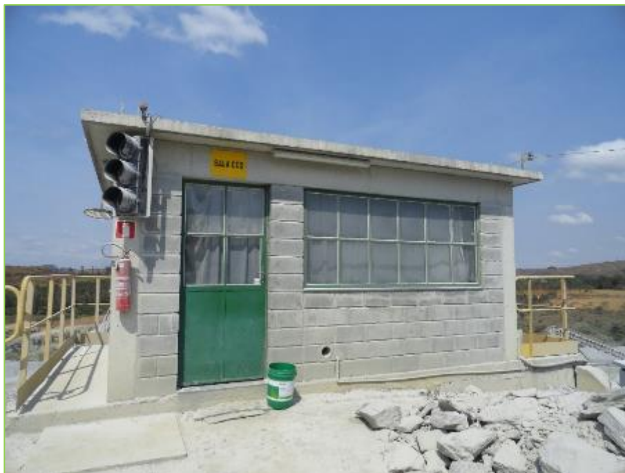
Figura 20: Sala de Controle da Unidade de Tratamento de Minério- UTM.
